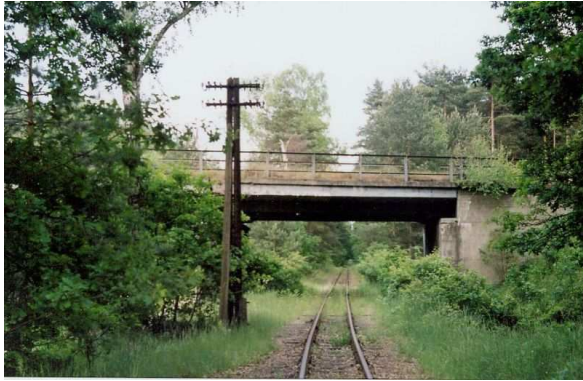
Wiadukt na linii kolei piaskowych
