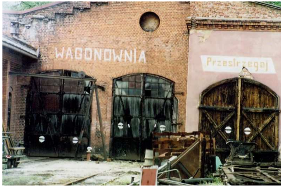
Wagonownia w Rudach
